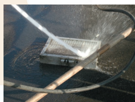
3 - Nettoyage de la cartouche filtre et remplacement une fois sur deux
