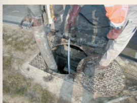
1 - Curage de la décantation
