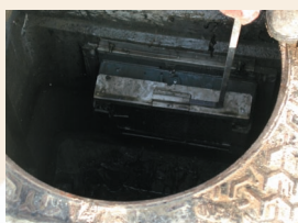
2 - Extraction du filtre de la bouche d'égout
